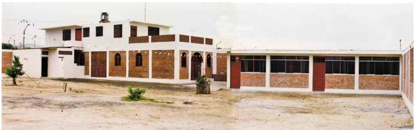
►Construcción en una capilla de la parroquia «San Luis Gonzaga».
